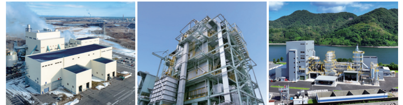
バイオマス発電プラント
