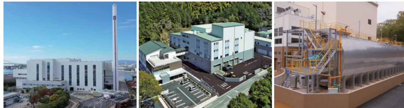
ごみ焼却プラント
