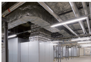
空調設備工事
