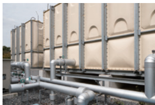
給排水衛生設備工事
