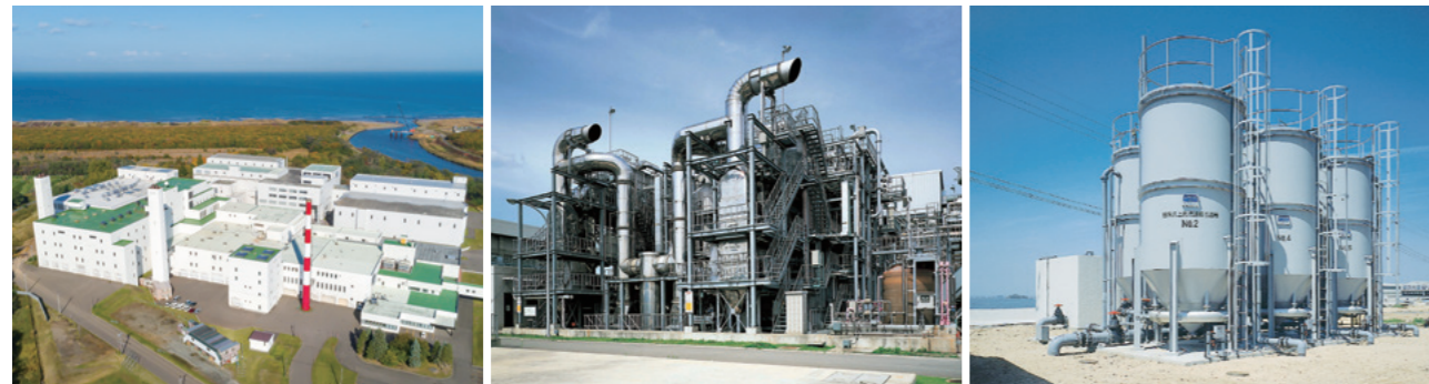
下水汚泥焼却発電プラント
