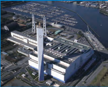
日本最大規模のごみ焼却プラント（東京都江東区）
