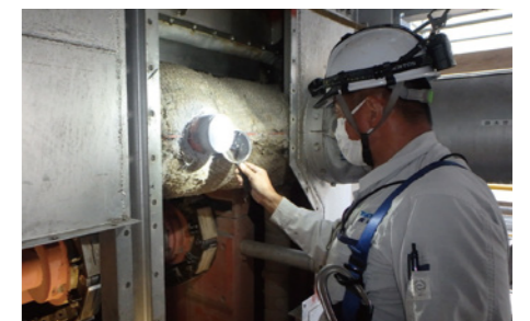
設備点検の様子
