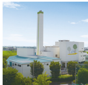
基幹改良 富士見環境センター
