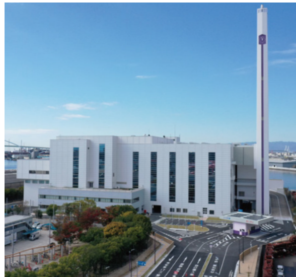
新設 大阪広域環境施設組合 住之江工場
