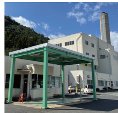
基幹改良 島後清掃センター
