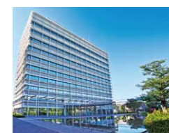
(9) 尼崎本社ビル
