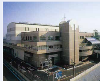
粗大ごみ破碎プラント
