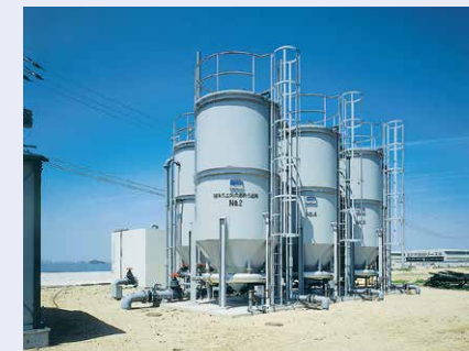
上向流移床型ろ過器
