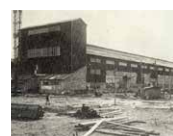
(2) 建設中の播磨工場
