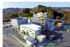
木質バイオマス発電プラント 発電出力:1,990kW
