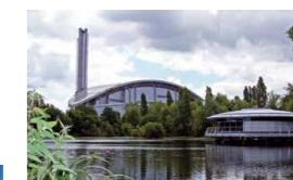
廃棄物発電プラント(英国) 処理能力:1,370t/日 発電出力:36,650kW
