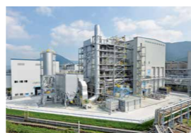
木質バイオマス発電プラント 発電出力:22,100kW
