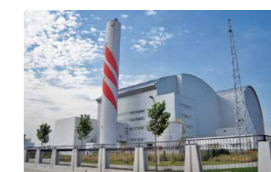
廃棄物発電プラント(中国) 処理能力:1,600t/日 発電出力:30,000kW
