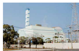
ごみ処理プラント(基幹的設備改良工事) 処理能力:810t/日 発電出力:17,200kW
