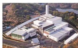
ごみ処理プラント(DBO事業) 処理能力:174t/日 発電出力:3,800kW
