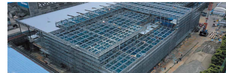
(播磨新工場 工事進捗写真) 撮影日:2022年6月16日 完成予定:2022年12月 設備投資額:約130億円
