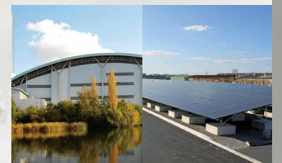
欧州で廃棄物 発電プラント納入 (2010年)
