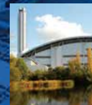
欧州で廃棄物 発電プラント納入 （2010年）
