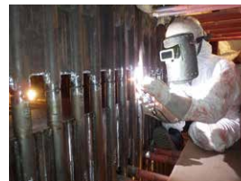
ボイラ水管の取替え
