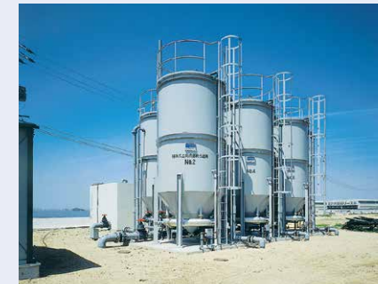
上向流移床型ろ過器
