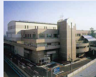
粗大ごみ破碎プラント
