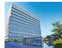
(9) 尼崎本社ビル
