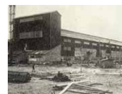
(2) 建設中の播磨工場
