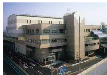
粗大ごみ破碎プラント
