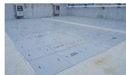
移床式上向流連続砂ろ過装置(高速型)
