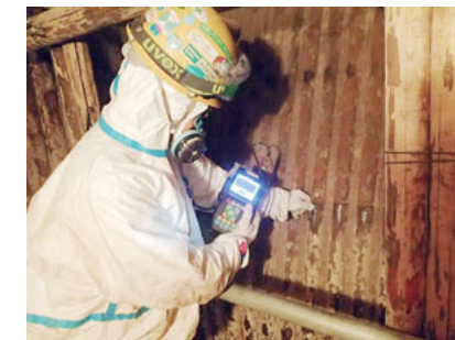
ボイラ水管の肉厚測定
