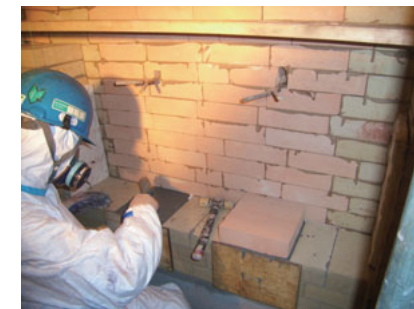
焼却炉耐火物の補修
