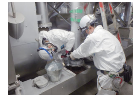
コンベヤの整備
