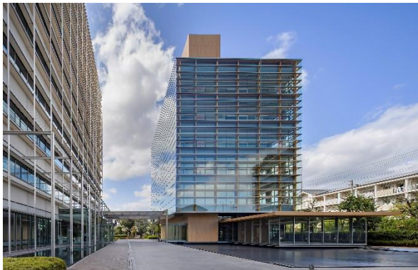
池に浮かぶタクマビル新館
