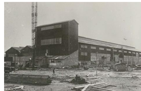
建設中の播磨工場
