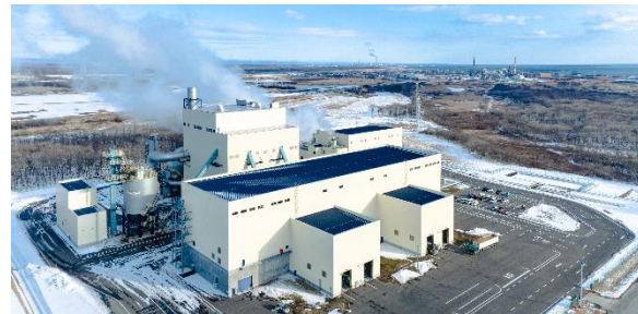
バイオマス発電プラント
