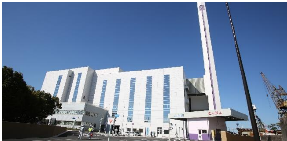
一般廃棄物処理プラント
