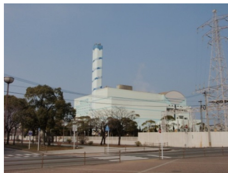
ごみ処理プラント（基幹的設備改良工事） 処理能力：810 t/日 発電出力：17,200kW
