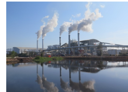
バガス燃焼ボイラプラント（タイ）
