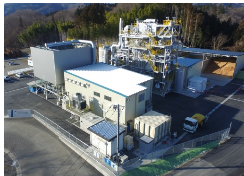
木質バイオマス発電プラント 発電出力：1,990kW
