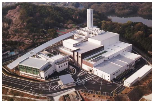
ごみ処理プラント（DBO事業） 処理能力：174 t/日 発電出力：3,800kW
