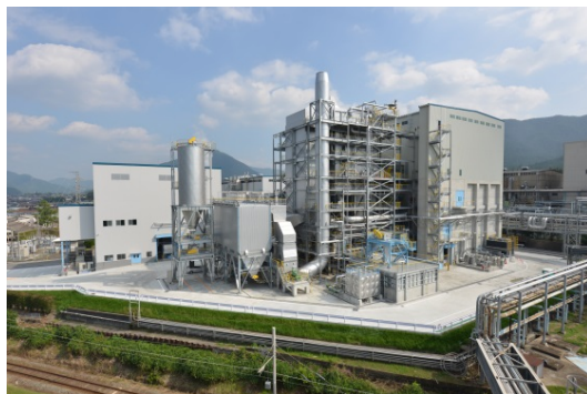
木質バイオマス発電プラント 発電出力：22,100kW
