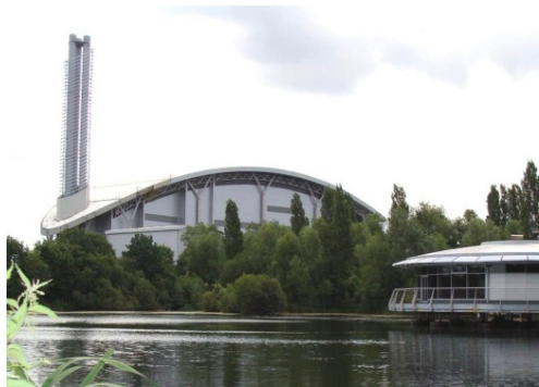
廃棄物発電プラント（英国） 処理能力：1,370 t/日 発電出力：36,650kW
