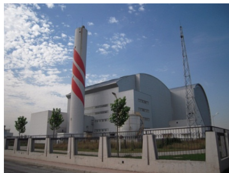
廃棄物発電プラント（中国） 処理能力：1,600 t/日 発電出力：30,000kW
