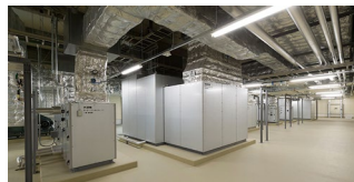
給排水衛生設備
