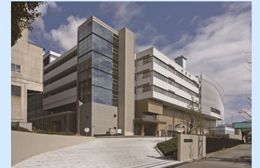
吹田市資源循環エネルギーセンター
