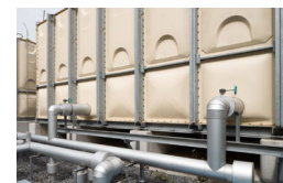
給排水衛生設備
