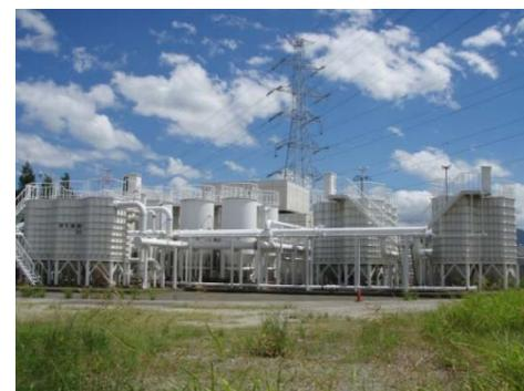
上向流移床型砂ろ過装置
