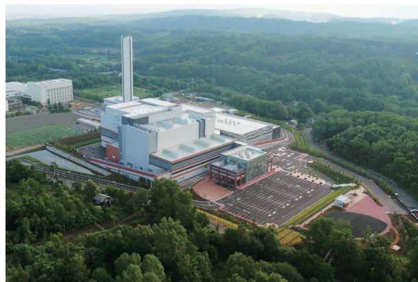
一般廃棄物処理プラント (札幌市駒岡清掃工場)
