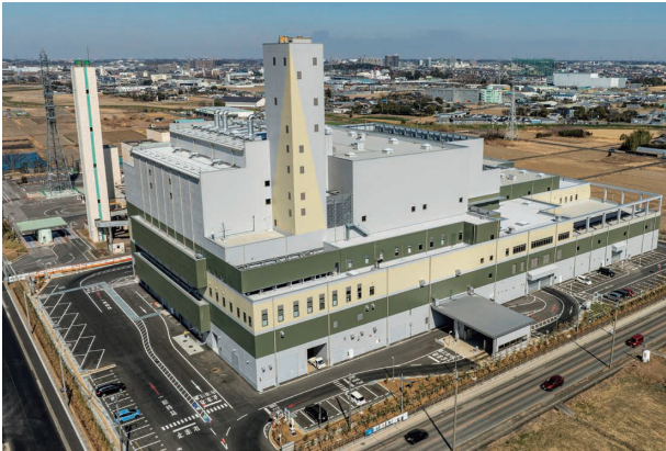
一般廃棄物処理プラント (さいたま市見沼環境センター)
