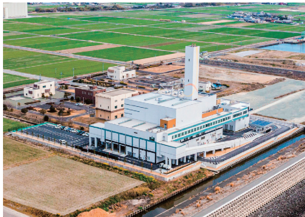
一般廃棄物処理プラント
