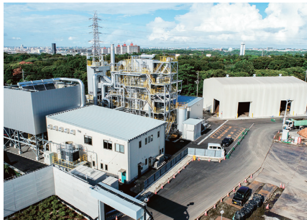
バイオマス発電プラント
