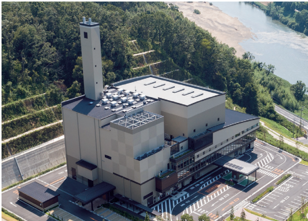
一般廃棄物処理プラント
