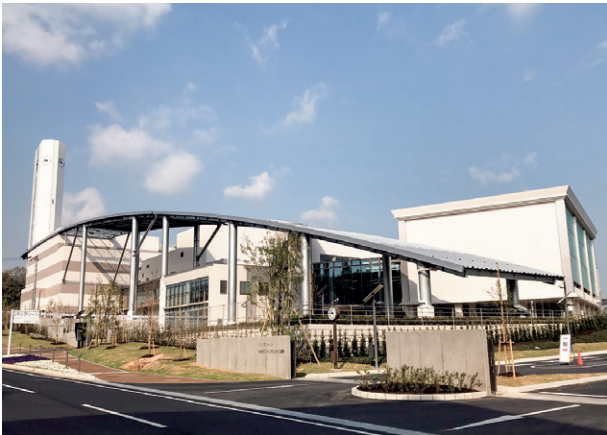
一般廃棄物処理プラント
