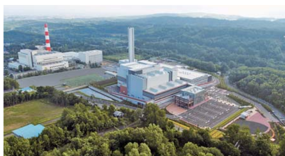
※ 写真奥の煙突と建屋は旧駒岡清掃工場
