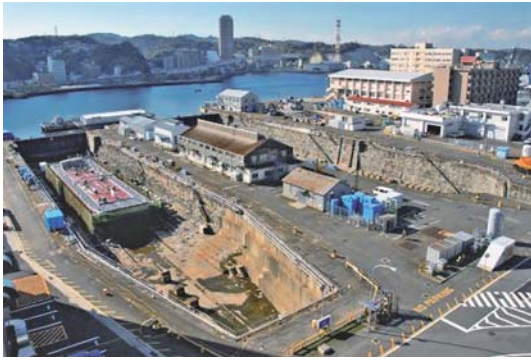
図2 日本初の横須賀造船所 1) （現在は米軍横須賀基地内）
