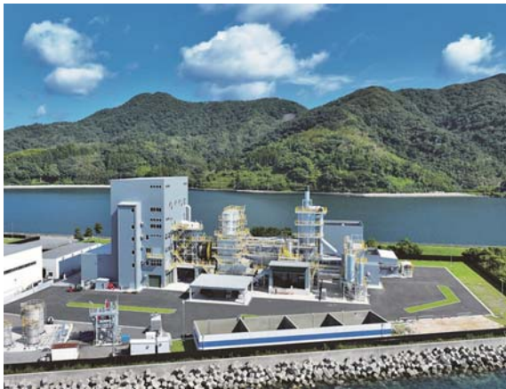
図3 廃棄物焼却発電施設（10号炉）の全景写真
