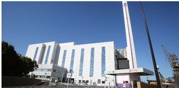
一般廃棄物処理プラント
