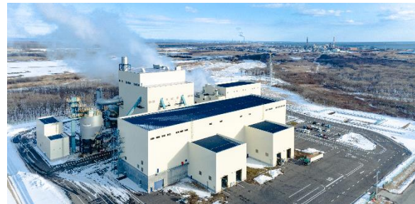
バイオマス発電プラント
